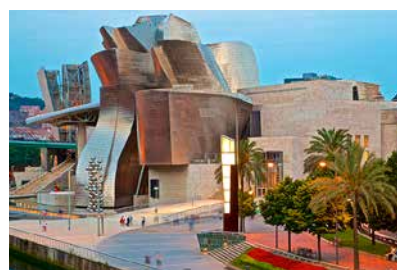
Lloses del Guggenheim (Bilbao)
