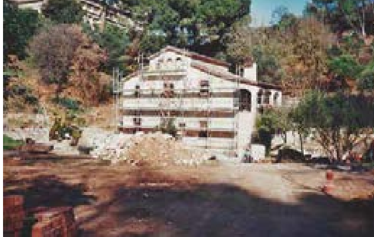
La bastida que es va muntar per a reformar la façana principal de la masia, durant l'any 1999.
