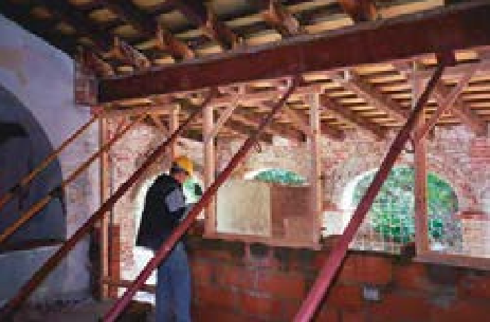
Les obres de la reforma de la terrassa, amb els envans i les parets de la primera planta de la masia, a càrrec de l'escola taller de Barcelona Activa, durant l'any 1999.
